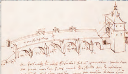
Voujeaucourt : pont douanier sur le Doubs
